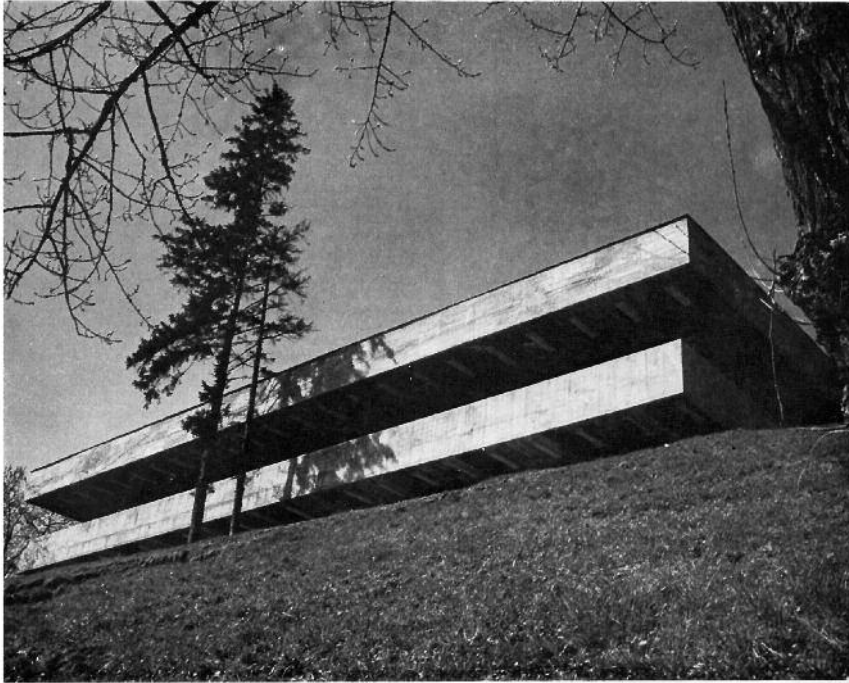
A város felőli, keleti homlokzat
