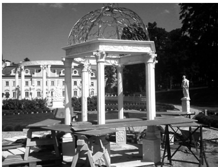
A kerti márvány pergola betonozási munkái, összeállítás, 2010
