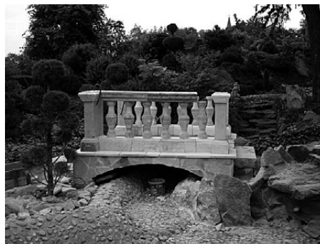
Híd építése a japánkertben, maradék kész kőelemekből hiányzó elemek faragása, 2014
